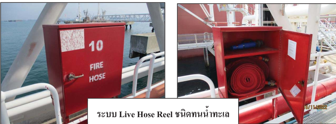
รูปที่ 8 ระบบดับเพลิงภายนอกอาคาร ใช้น้ำทะเลเป็นแหล่งน้ำดับเพลิง
