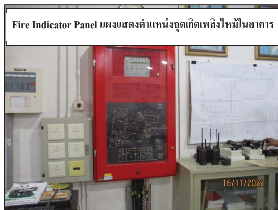
รูปที่ 11 ระบบแจ้งเตือน และระบบดับเพลิงภายในอาคาร
